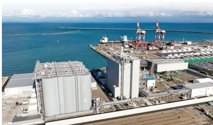
（御前崎港バイオマス発電所／2024年2月撮影）
